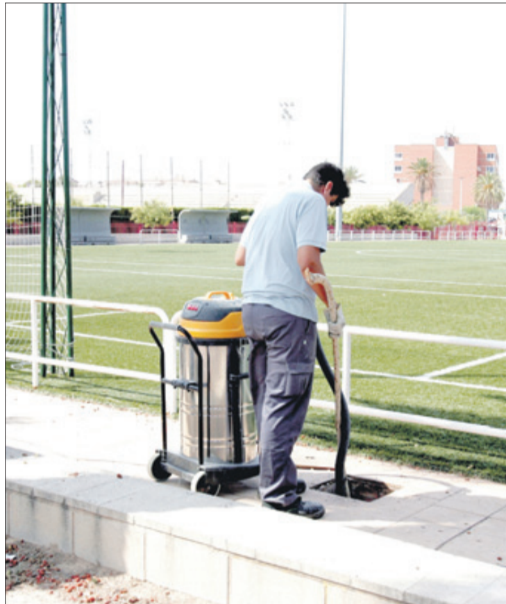
Un operario trabajando en la Ciudad Deportiva. DIEGO FOTÓGRAFOS
